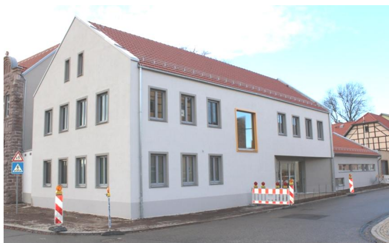
Ansicht von Nordosten (Ecke Schlossstraße-Jungferstieg)
