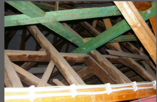
Dachgeschoss und Dacheindeckung
