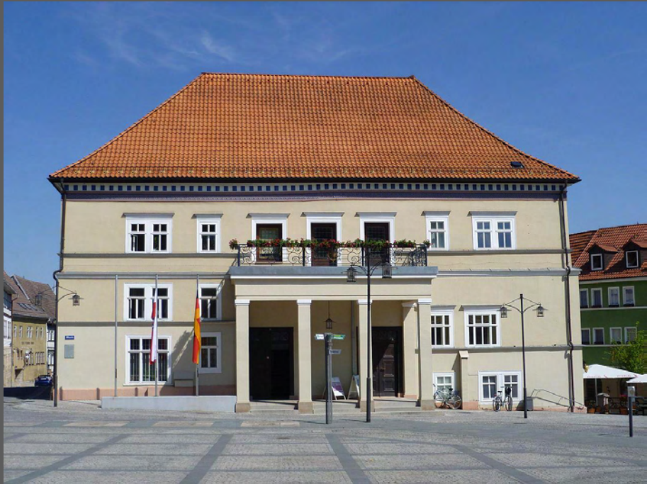
Hauptfassade Markt Bestand
