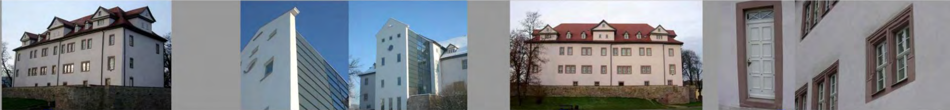
stadtschloss bad frankenhausen
