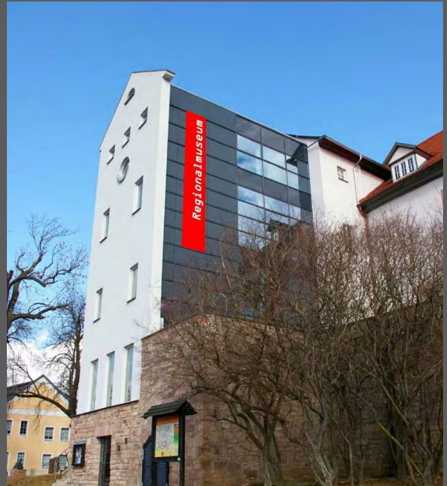
Stadtschloss BF: vorgehängtes hinterlüftetes Fassadensystem, System Trespa, 2011
