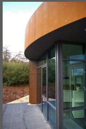
Stadtschloss BF: vorgehängtes hinterlüftetes Fassadensystem, System Trespa, 2011
