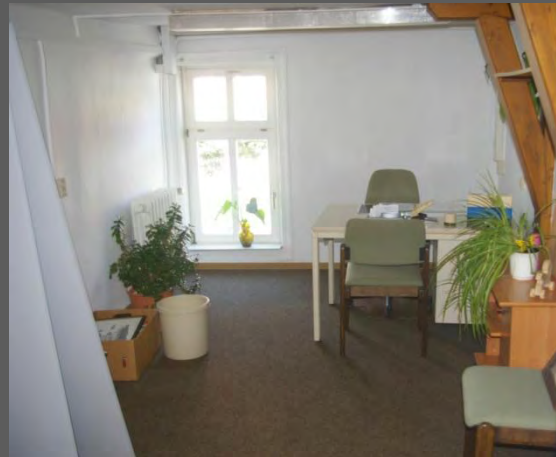
Problematik Raumhöhen, Sturzhöhen
