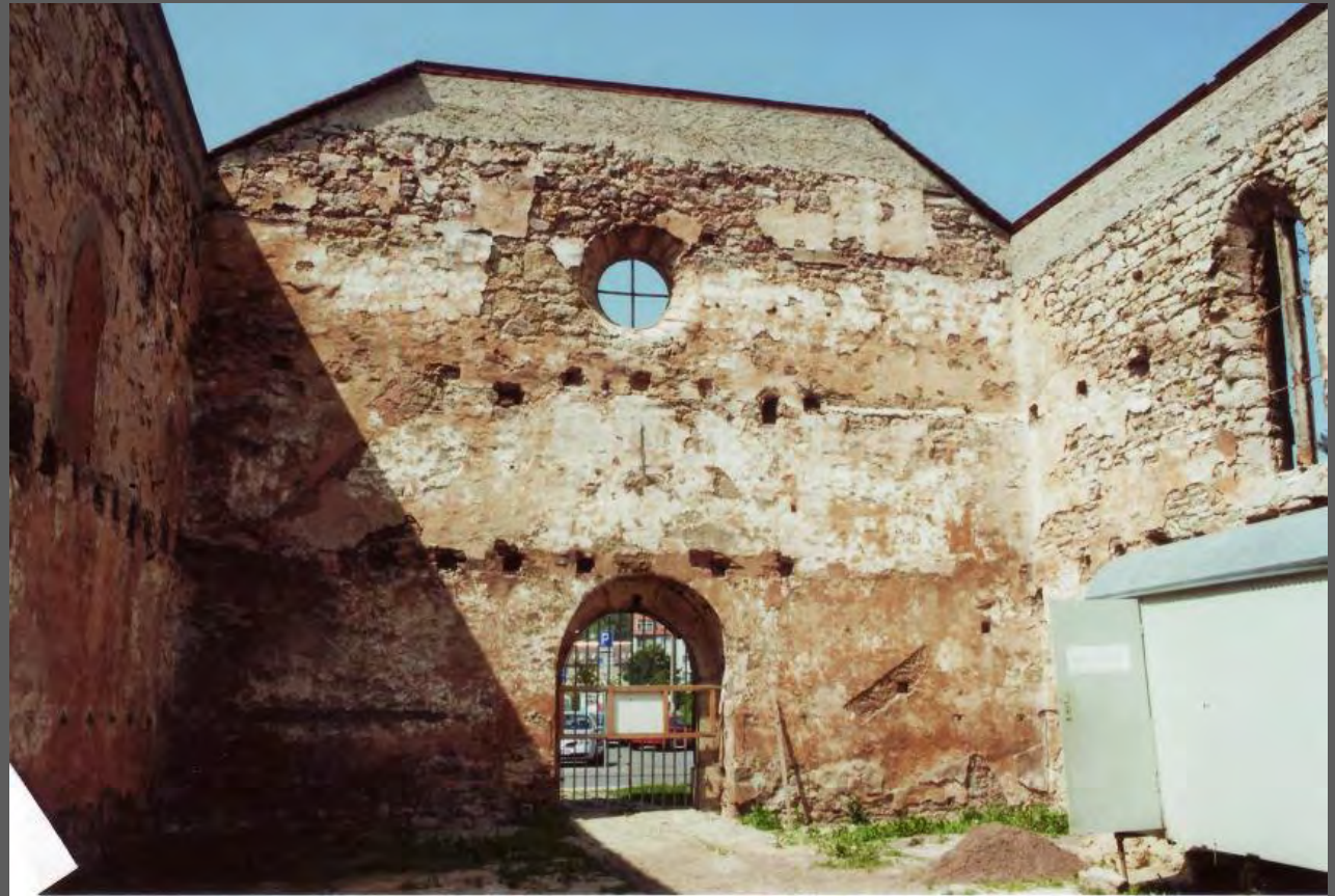
Ansicht der Westwand (Zustand 2007)
