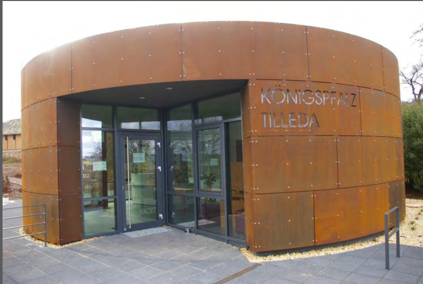
vorgehängtes hinterlüftetes Fassadensystem CORTEN-Stahl, 2013
