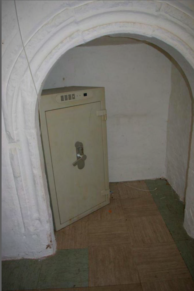
Originales Renaissancegewände, Keller
